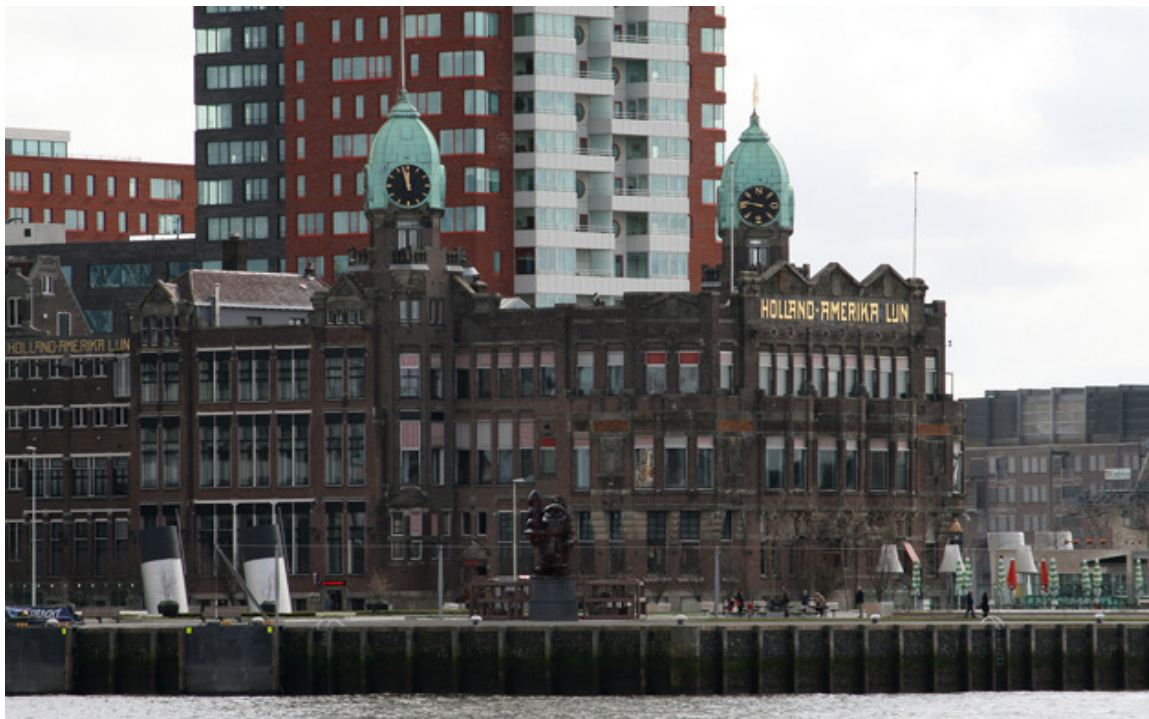
Foto en montage – Daniëlla Franken
